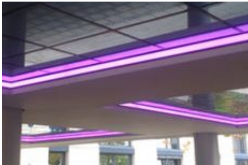
Abbildung 8.25.: RGB-Voute im Außenbereich
